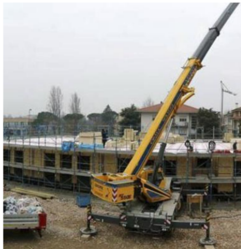
I lavori alla nuova scuola elementare Montessori di via Cuneo
